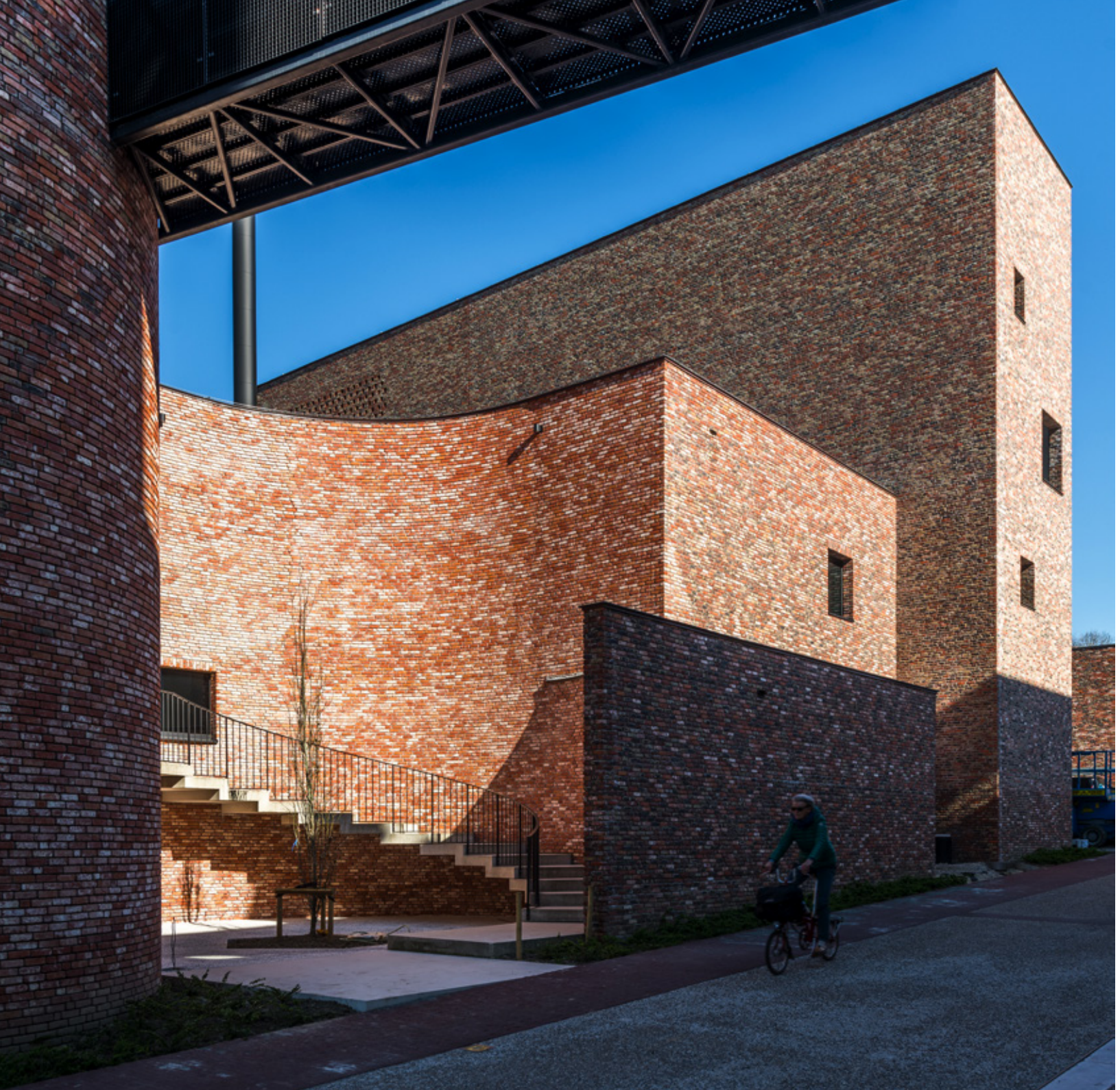
Architecten- en ingenieursbureau D'hondt Beyens Goesaert DBG in collaboration with Claeys-Haelvoet architecten, Kortrijk
