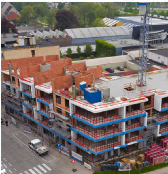
Apartment building 'Caendel', Deinze Atelier voor Stedelijke Architectuur, Ghent
