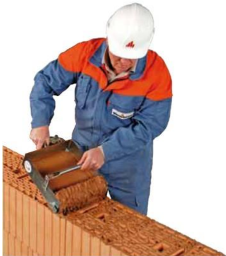
Brique rectifiée pour Maçonnerie Roulée® et DRYFIX®
