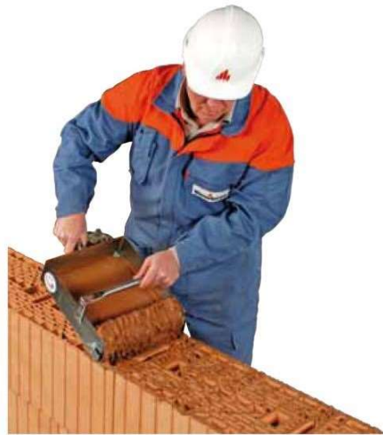
Brique rectifiée pour Maçonnerie Roulée® et DRYFIX®
